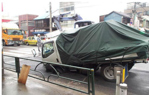
図 2-5 管渠の老朽化・損傷にともなう道路陥没の事例
